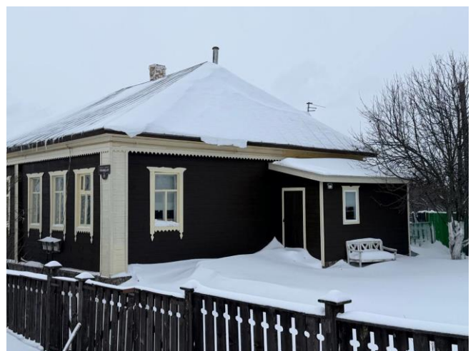
12 нче рәсем. Төньяк-көнчыгыш фасады
