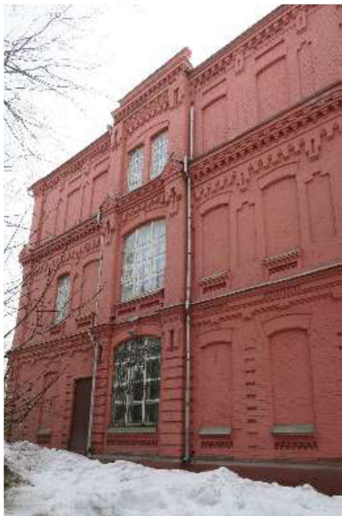
24 нче рәсем. Өч катлы күләм (Литер А1). Чын куышлар, тәрәзә уемнары, тәрәзә төбә һәм тәрәзә яссылыклары, кат арасы һәм түбә кәрнизләре, ризалит аттигы
