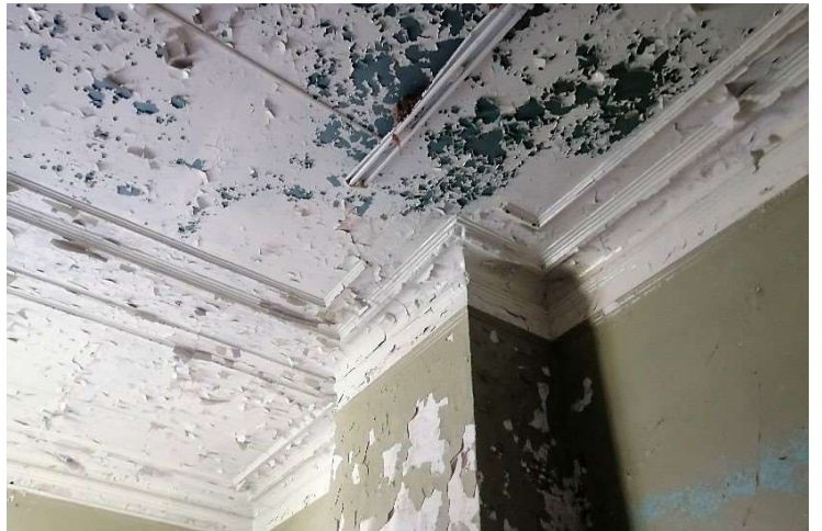
28 нче рәсем. Профильле тартмалар һәм падуга белән тоташтырылган түшәм плафоннары фрагменты
