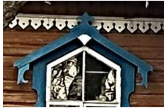
16 нчы рәсем. Почмаклар төгәлләнгән тәрәзә йөзлегенә фрагменты
