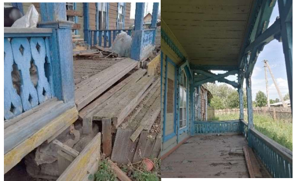
13 нче рәсем. Горизонталь юнөлөш бирүчө һәм вертикаль жыелма фигуралы такталар рәвешендәге агач киртә фрагменты
