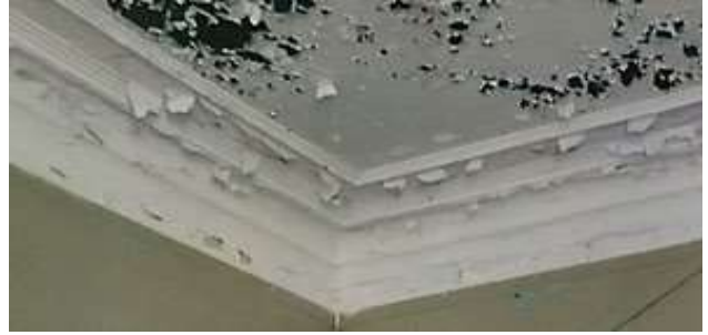
30 нчы рәсем. Профильле тартмалар һәм падуга белән тоташтырылган түшәм плафоннары фрагменты
