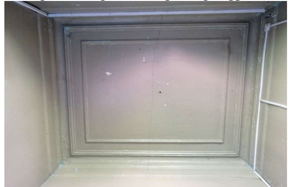
31 нче рәсем. Стеналар периметры һәм падуга белән тоташтырылган түшәм плафоннары буенча профильле гипс тартмалар
