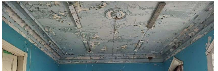
27 нче рәсем. Интерьер фрагменты. Стеналар периметры һәм падуга белән тоташтырылган түшәм плафоннары буенча профильле гипс тартмалар
