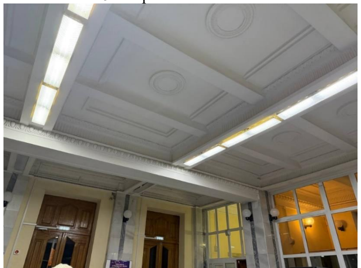
26 нчы рәсем. Вестибюль түшәме
