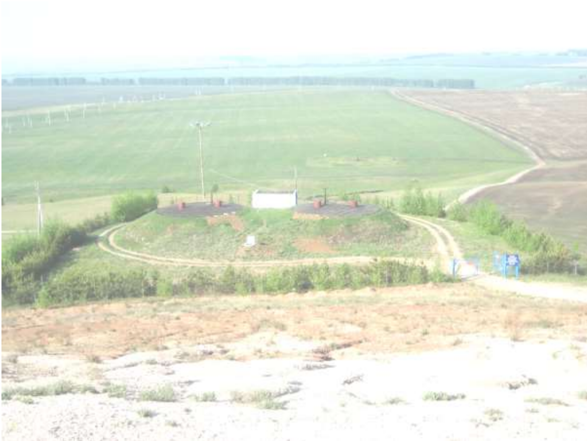
Чатра су жыю скважинасында Чиста су резервуары
