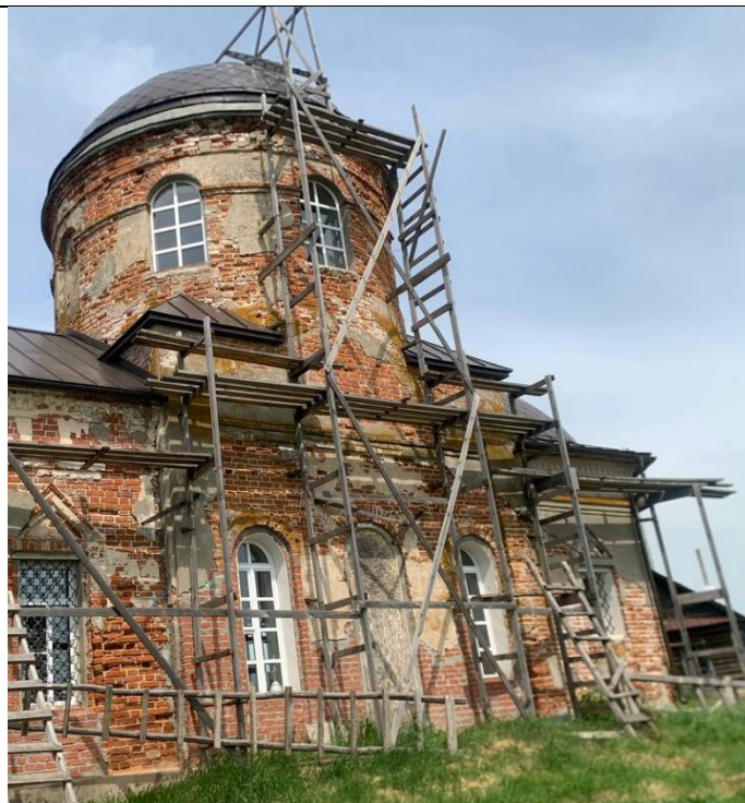
11 нче рәсем. Көнъяк фасады
