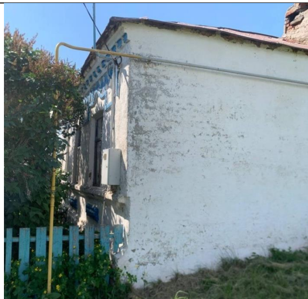
3 нче рәсем. Көнъяк фасады
