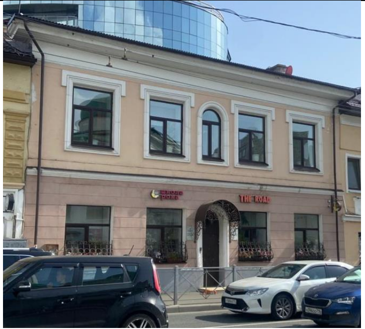
20 нче рәсем. 2 нче кибет. Көнъяк-көнбатыш фасады
