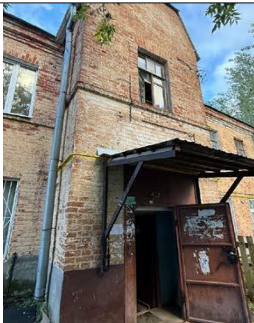
22 нче рәсем. Көнчыгыш юнәлештәге күренеш. Ишегалды фасады
