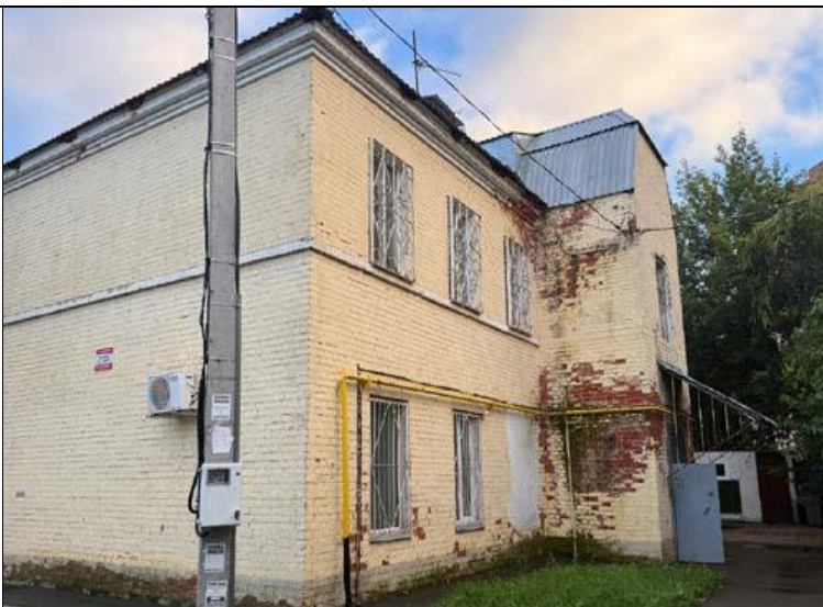
26 нче рәсем. Көнъяк юнәлештәге күренеш. Ишегалды фасады
