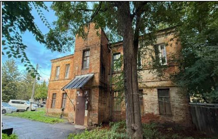
29 нче рәсем. Көнчыгыш юнәлештәге күренеш. Ишегалды фасады
