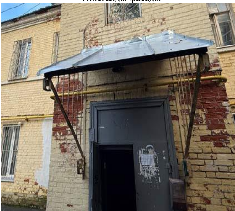
27 нче рәсем. Көнчыгыш юнәлештәге күренеш. Ишегалды фасады
