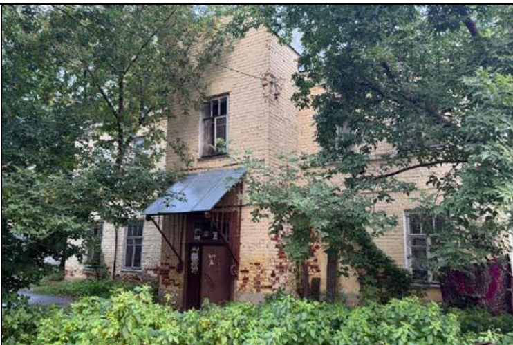
32 нче рәсем. Төнъяк-көнчыгыш юнәлештәге күренеш. Ишегалды фасады
