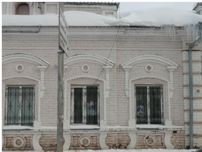
7 нче рәсем. Тәрәзә күчәре һәм тәрәзә төбөндәге фигуралы куыш буенча түгәрәк декоратив элементлы консольләрдә профильле йөзлекләр белән уратып алынган жәяле формадагы тәрәзә уемнары
