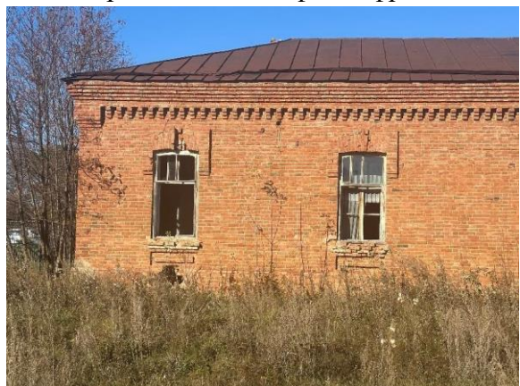
15 нче рәсем. Көнъяк-көнбатыш фасад фрагменты
