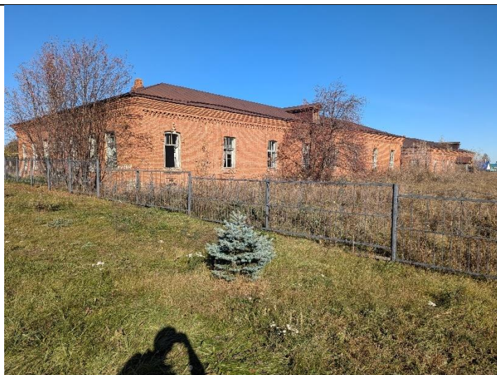
16 нчы рәсем. Көнъяк-көнбатыш фасад
