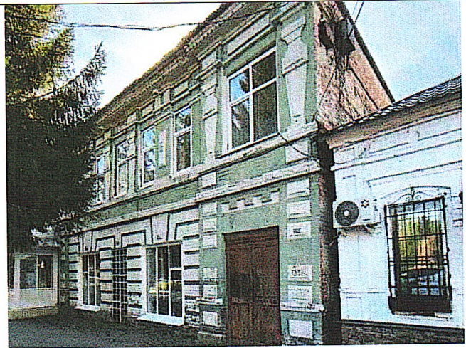
Рис.4. Вид на юго-восток. Главный фасад
