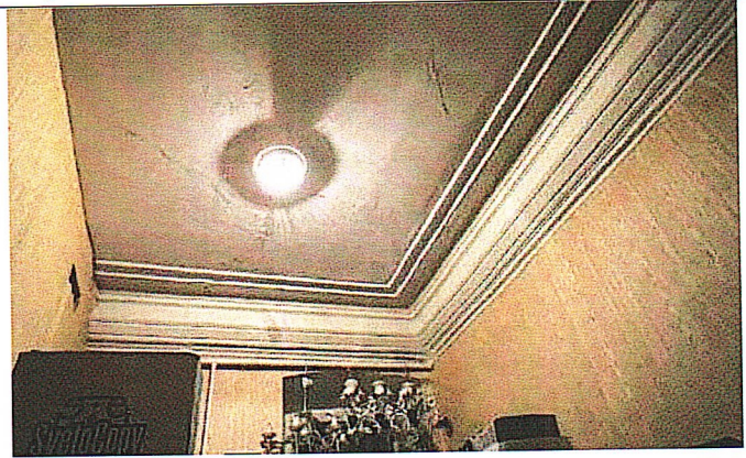
Рис.16. Подсобное помещение на втором этаже с историческим профильным карнизом
