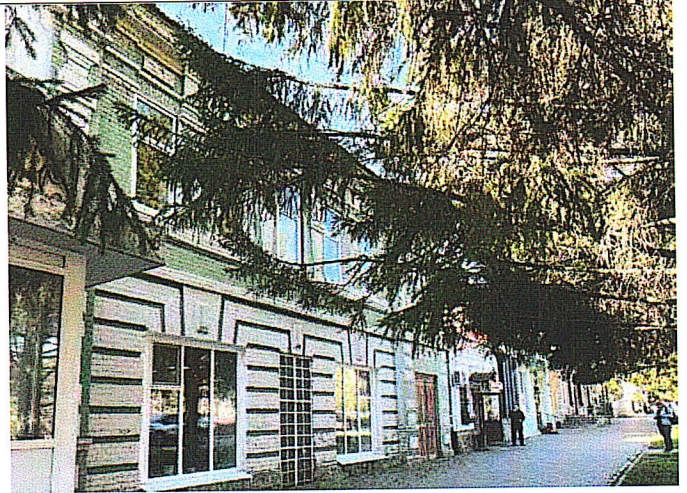
Рис.3. Вид на запад. Главный фасад
