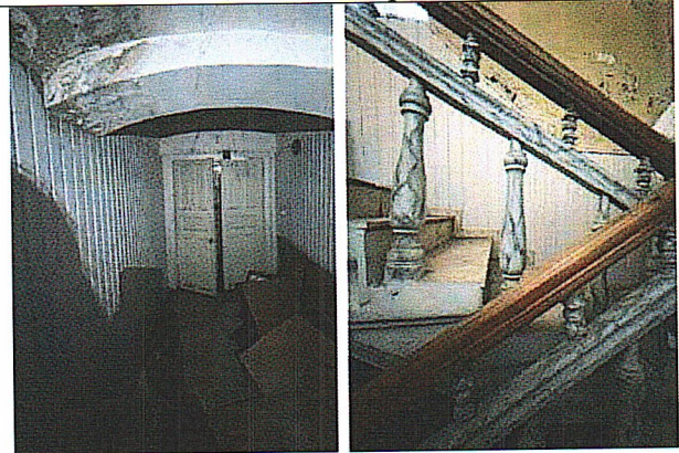
Рис.14-15. Административно-складское помещение на втором этаже. Балясина лестницы, расположенный за ризалитом
