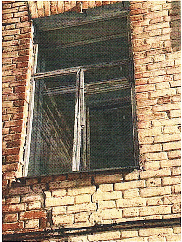
Рис.7. Вид в северо-восточном направлении на дворовый фасад здания. Окно второго этажа
