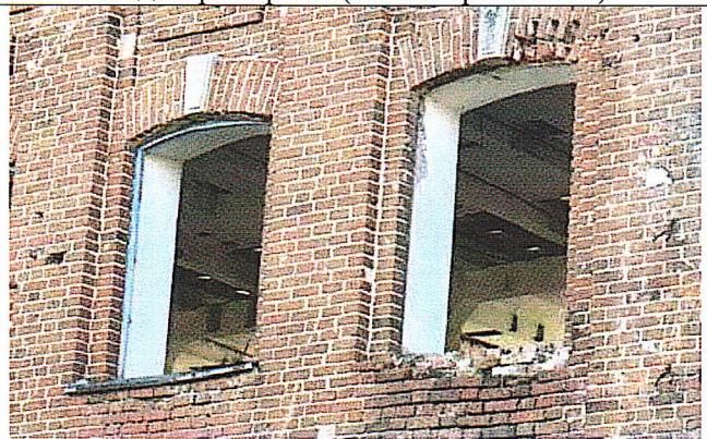
Рис.9. Не оштукатуренная кирпичная кладка
