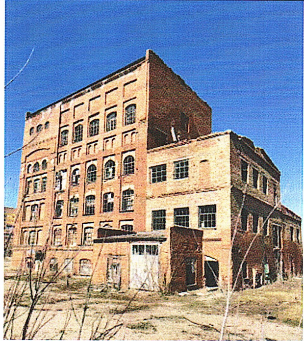
Рис.7. Вид главного фасада с юга с поздними наслоениями в виде пристроев (не исторические)
