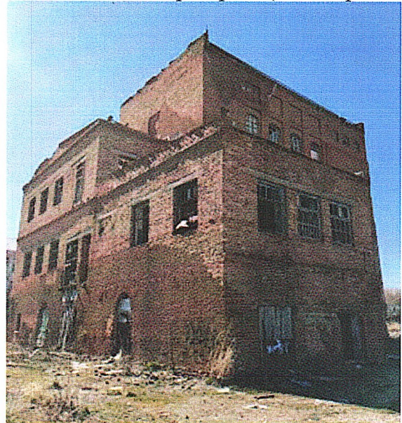
Рис.8. Вид с востока с поздними наслоениями в виде пристроев (не исторические)
