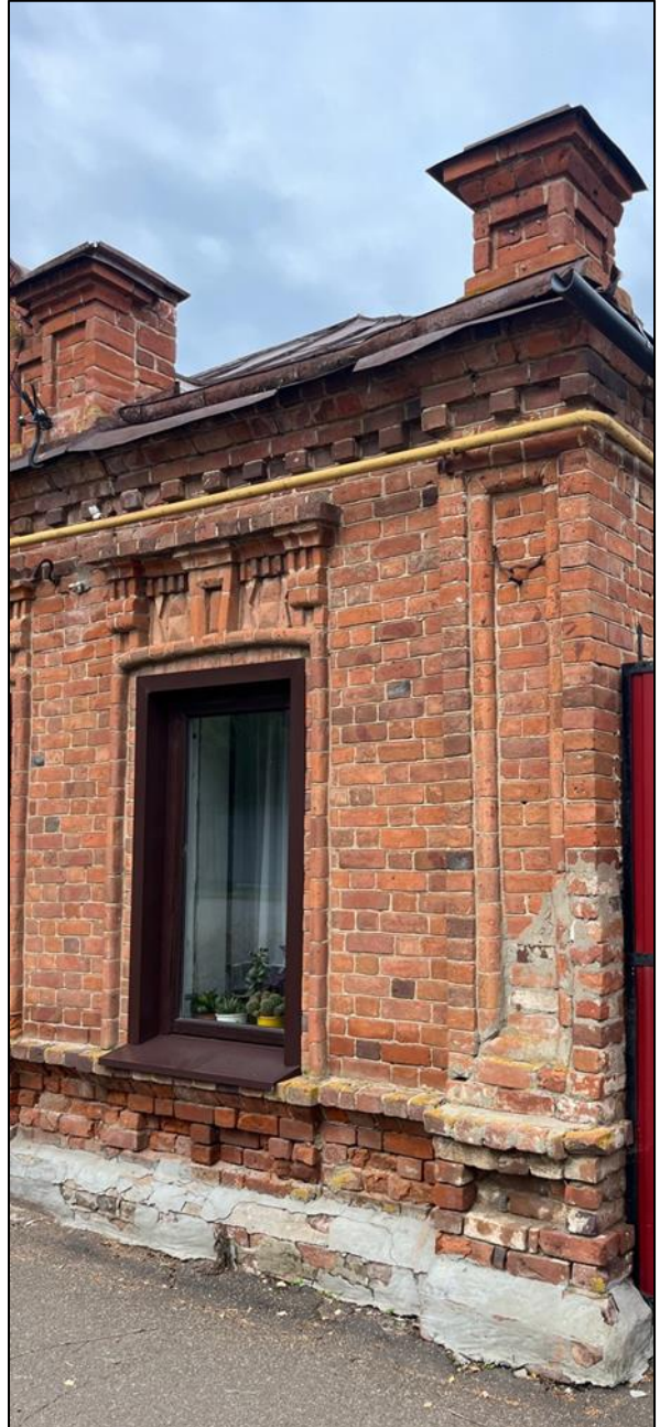
11 нче рәсем. Йозак ташы һәм сандриклы тәрәзә уемы. Парапет тумбасы. Кирпеч өеме
