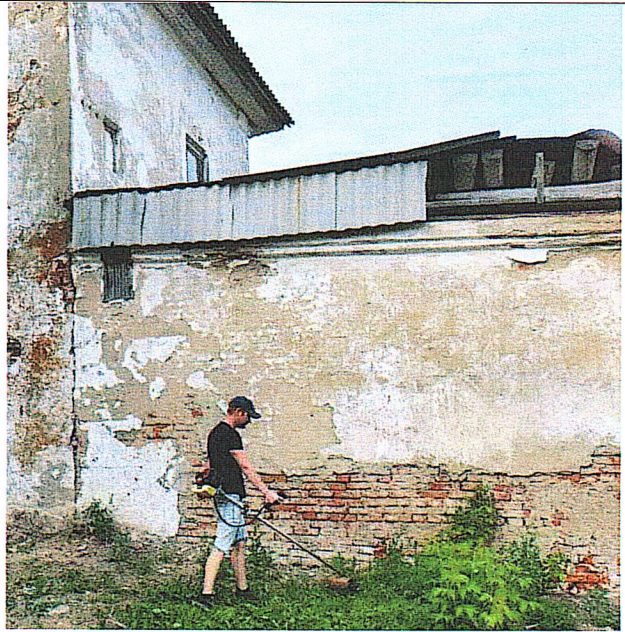
Рис.12 Вид с юго-запада
