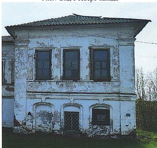
Рис.8 Вид с северо-востока
