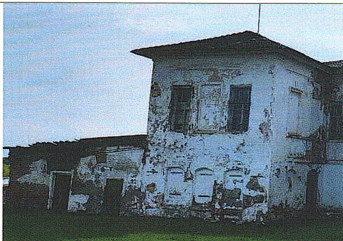
Рис.9 Вид с северо-востока
