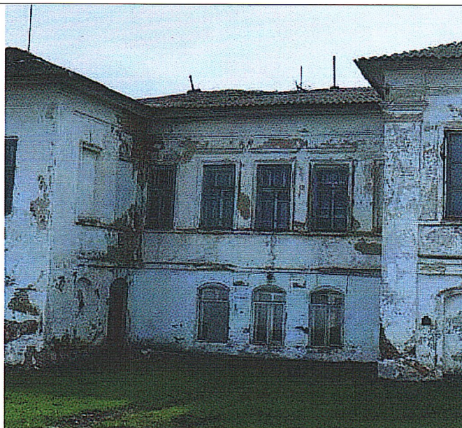
Рис.3. Вид с северо-востока
