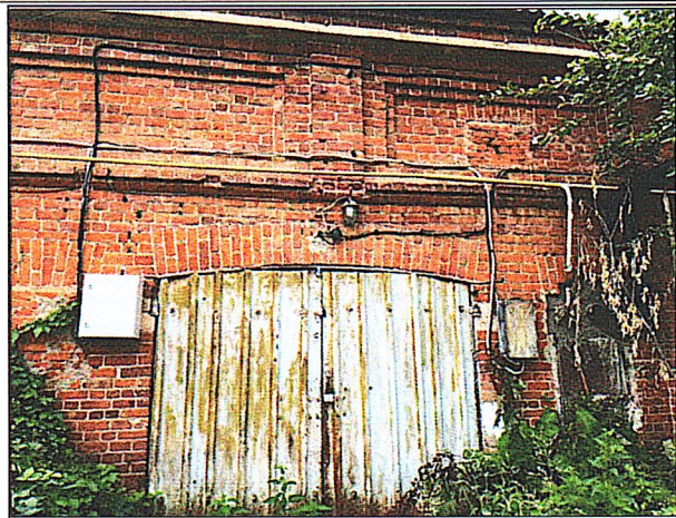
Рис.12. Восточный дворовой фасад. Проем с лучковой перемычкой, венчающий фриз с лопатками и нишами
