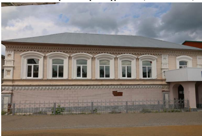
5 нче рәсем. Ленин урамы буенча көнъяктан хәрәкәт иткәндә көнъяк фасад күренеше (3 нче нокта)
