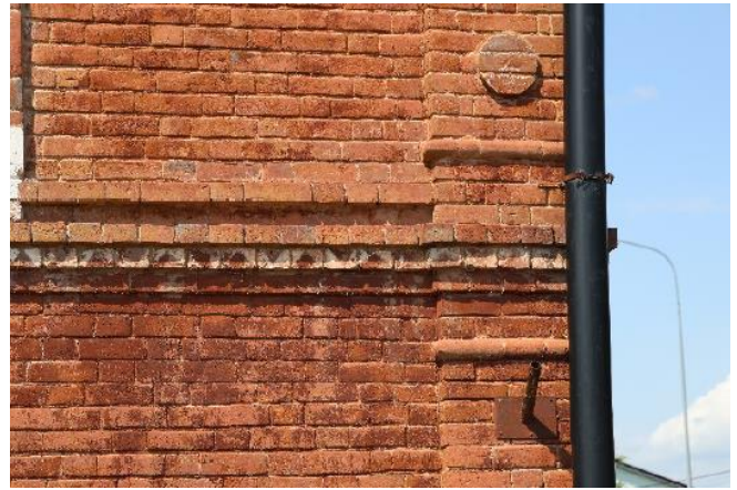
13 нче рәсем. Икенче каттагы тәрәзә уемнарының тәрәзә төбөндәге баскычлы кәрниз
