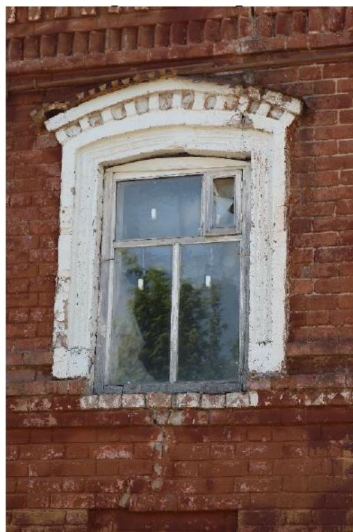
19 нчы рәсем. Икенче каттагы тәрәзә уемнарының киң рамлы йөзлекләре, сохари сандриklары белән төгәлләнеп һәм просанлы металл табактан өслек белән капланган
