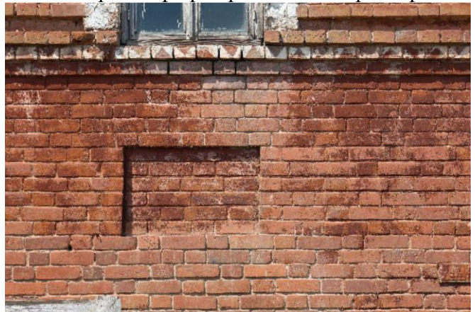
16 нчы рәсем. Икенче кат тәрәзәләренең тәрәзә төбөндәге турыпочмаклы куышлар
