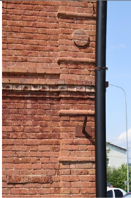
15 нче рәсем. Һәр сигезенче рәттә валиклы һәм декорсыз түгәрәк розеткалы көрәкләр
