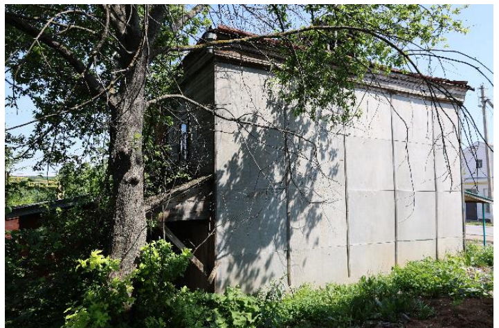
17 нче рәсем. Көнъяк фасад ягыннан баскыч шакмагының агач күләме, түбәсе кәрниз белән тәмамлана
