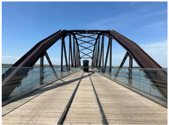
4 нче рәсем. Гомуи күренеш. Клепкалы фермалар конструкциясе
