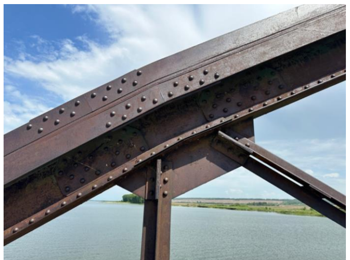
5 нче рәсем. Клепкалы фермалар конструкциясе
