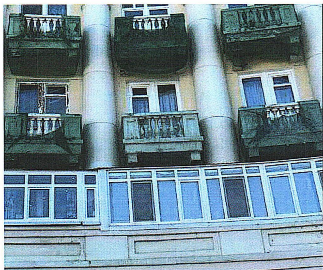
Рис. 9. Балконы уличного фасада
