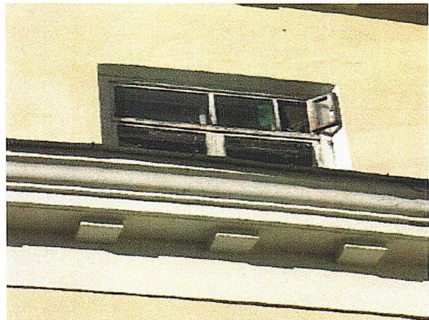
Рис. 4. Фрагмент карниза уличного фасада
