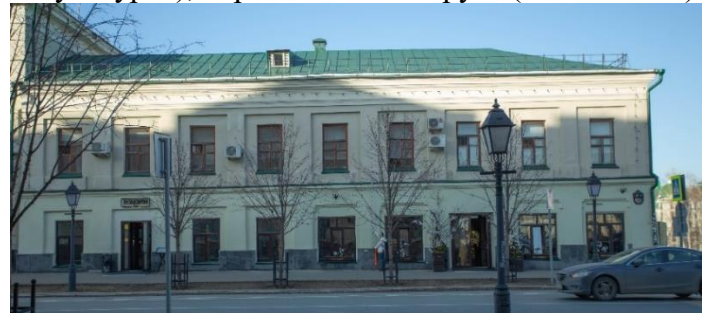
36 нчы рәсем. Кремль урамындагы күренеш (фасадларның бизәлеше – буяулы шомаштукатурка)
