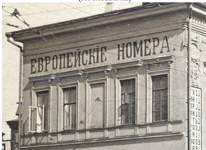
33 нче рәсем. Икенче каттагы тәрәзә уемнары астындагы тумбалы нечкә декоратив пояс; икенче каттагы тәрәзә уемнарының ике кронштейнында сандриклы профильле йөзлекләр; кат арасындагы тарттыргычлар; югары профильле түбә кәрнизе
