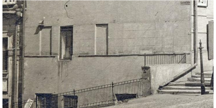
35 нче рәсем. Миславский урамындагы фасад (фасадларның бизәлеше – буяулы шомаштукатурка); беренче каттагы руст (югалтылган)
