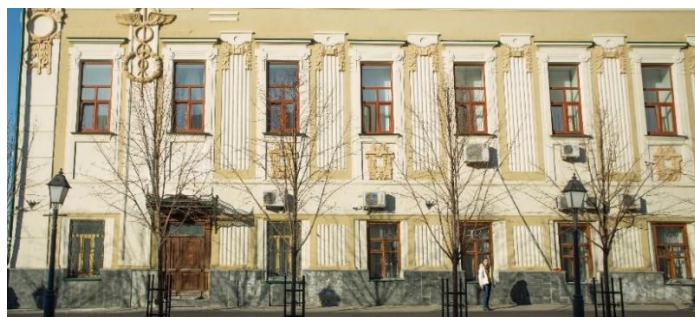
14 нче рәсем. Яссы, горизонталь кат арасындагы тарттыргыч
