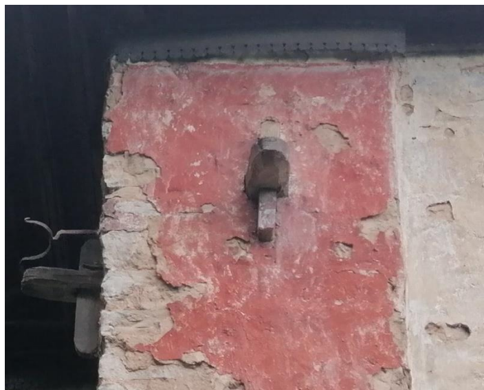
Рәсем. 32. Таш диварлардан чыгып торучы, конструктив бәйләнеш ясаучы агач элементлары
