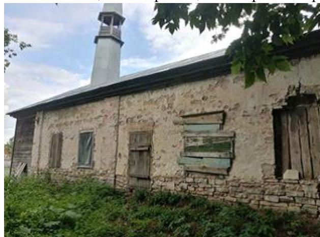
Рәсем 20. Көнбатыш фасад фрагменты
