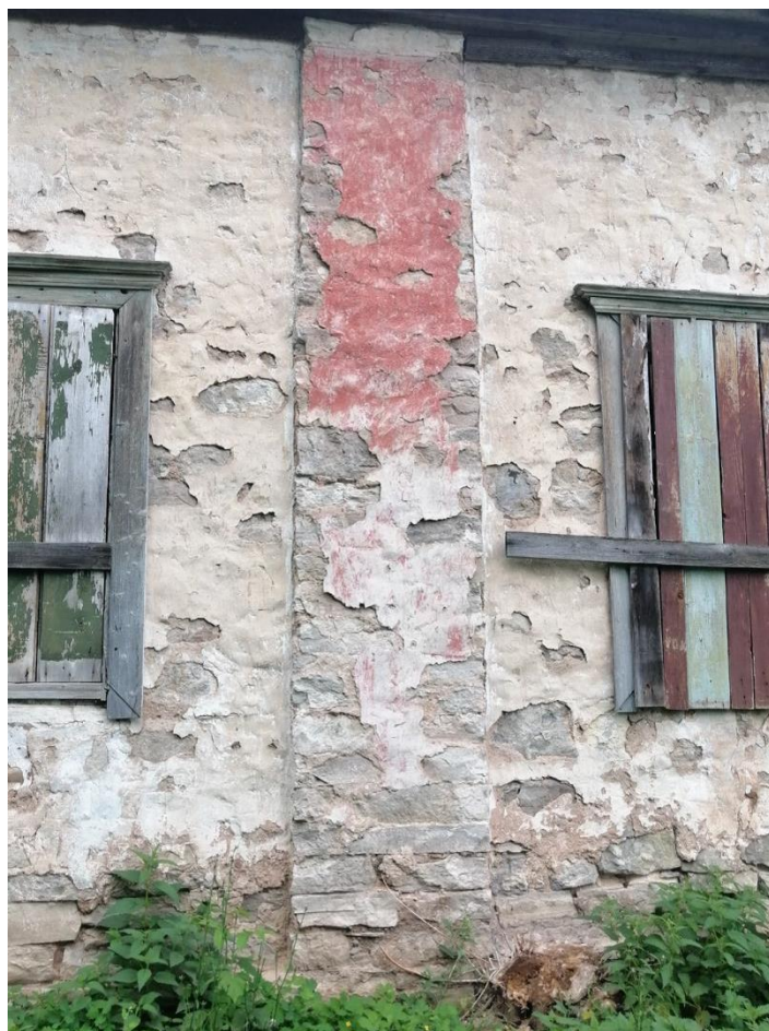
Рәсем 33. Көнчыгыш фасадтагы пилястрлар
