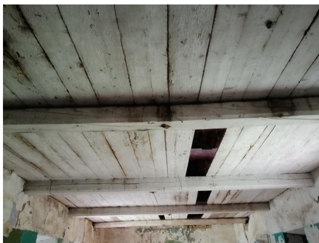
Рәсем. 38. Түбәнең агач конструкцияләре
