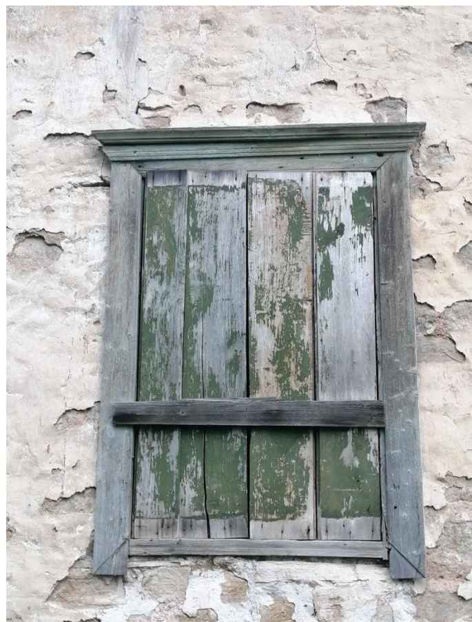
Рәсем. 35. Яссы йөзлекләр белән раманган турыпочмаклы тәрзә уемнары баскычлы профильле кәрниз рәвешендә тәмамланган
