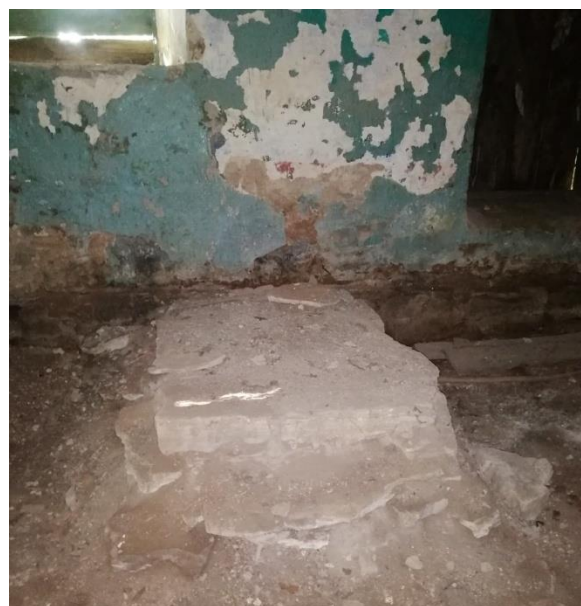
Рәсем. 9. Фундаментның дивар яссылыгынан чыгып торугы
