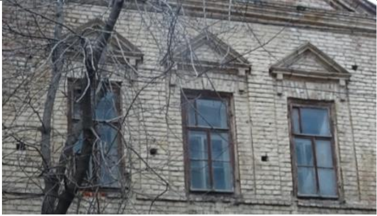
7 рәсем. Фасадның үзәк өлешенә 2 нче катындагы тәрәзә уемнары кронштейннара өчпочмаклы профильле сандриklar һәм йомык ташлар белән
