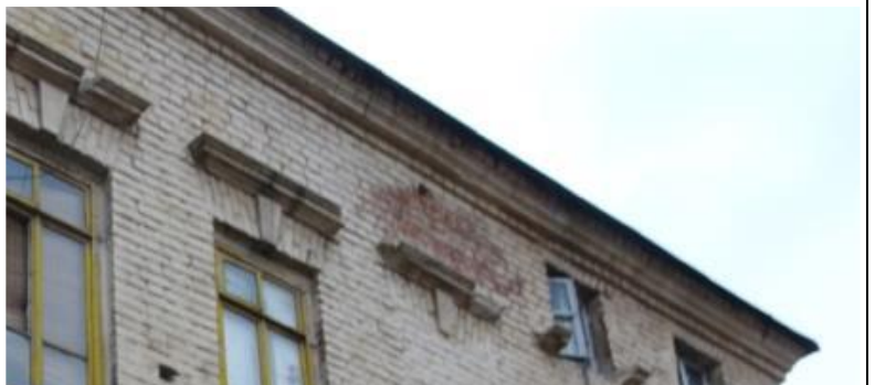
15 рәсем. Профильләштерелгән кәрниз
