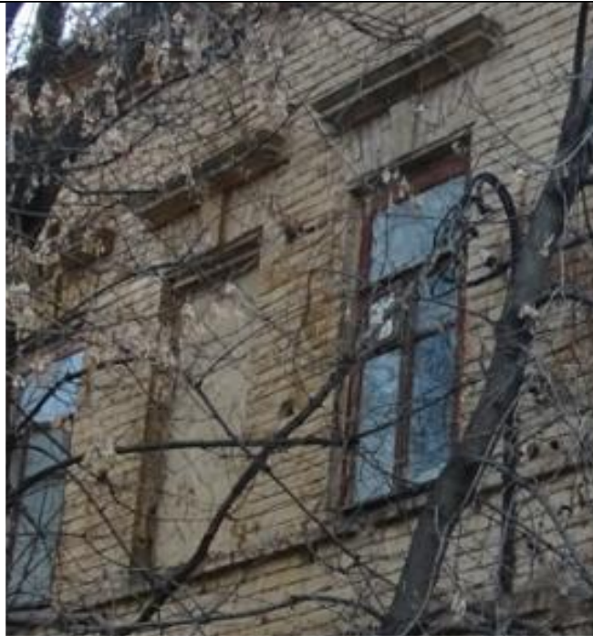
22 рәсем Икенче катның профилирланган карниз һәм йомык ташлар рәвешендәге сандриклары белән турыпочмаклы биек тәрәзә уемнары
