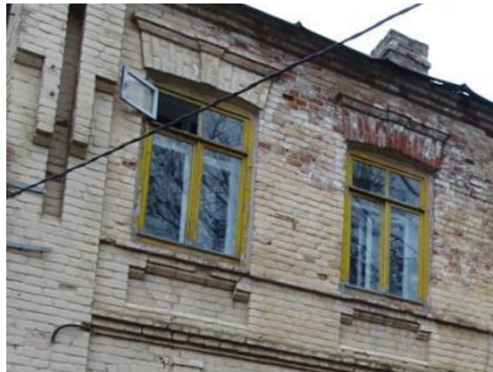
18 рәсем. Чыгыш ясаучы нур тамгалары, йозак ташлары һәм турыдан-туры жәелгән профильле карниз рәвешендәге сандриklar белән 2 нче катның тәрзә уемнары
