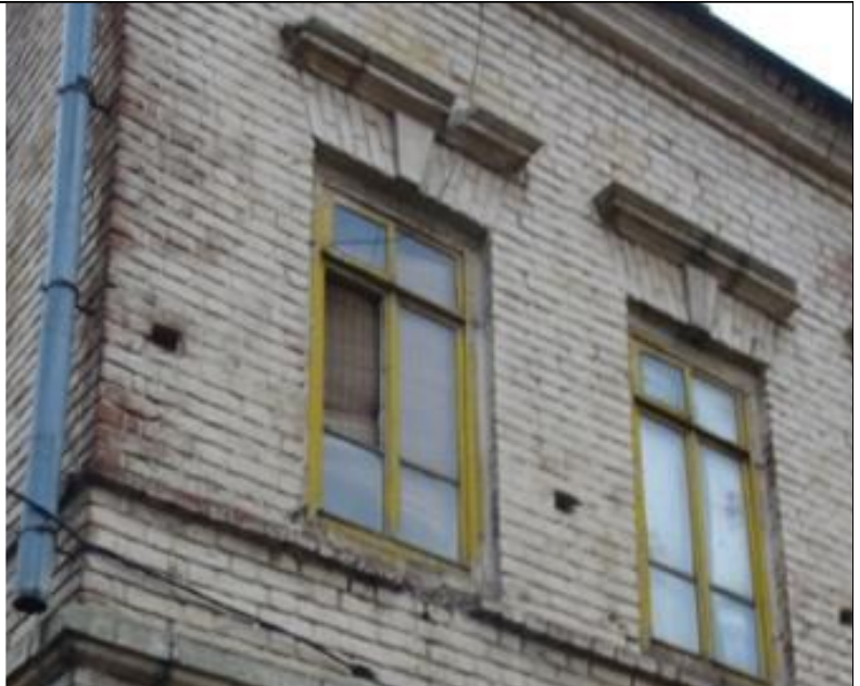
13 рәсем. Икенче катның профильләштерелгән карниз һәм йомык ташлар рәвешендәге сандриклары белән турыпочмаклы биек тәрәзә уемнары
