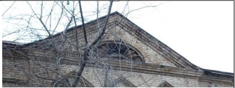
10 рәсем. Ярым циркуль тәрәзә уемлы үзәк ризалитның өчпочмаклы фронтоны
