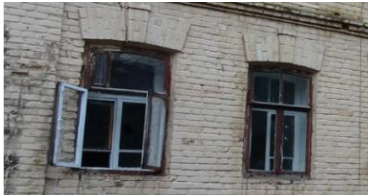
17 рәсем. 1 нче катның чыгыш ясаучы нур тамгалары һәм йозак ташлары булган тәрзә уемнары
