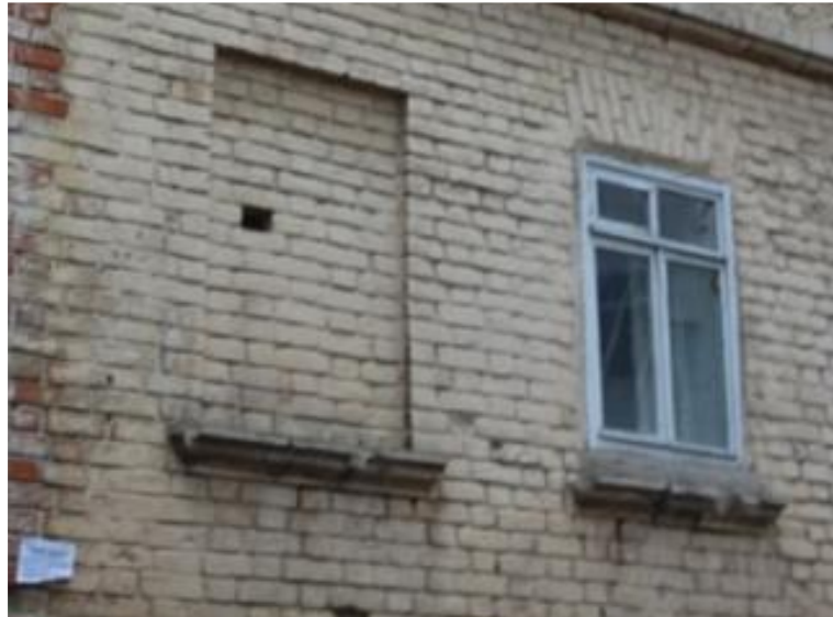
12 рәсем. Беренче каттагы тәрәзә уемнары һәм куышлары, формасы буенча - квадрат, тәрәзә асты киштәләренә яқын.
