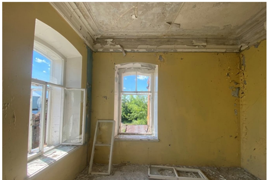
22 рәсем. Профильле тягалар белән 2 нче кат бинасының фрагменты
