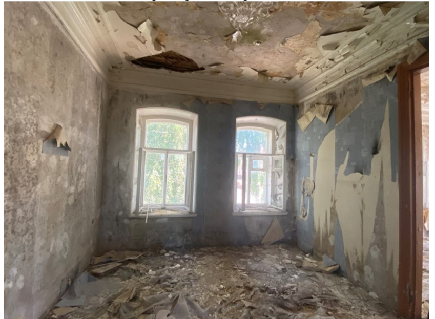
24 рәсем. Профильле тягалар белән 2 нче кат бинасының фрагменты
