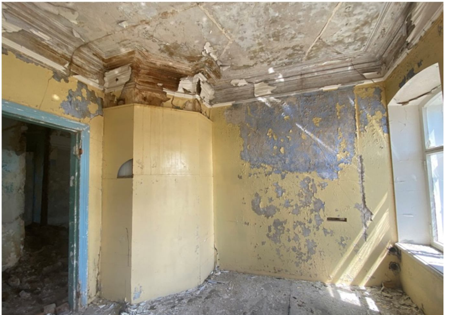
21 рәсем. Икенче катның диагональ мичле һәм профильле түшәм тягалары булган фрагменты
