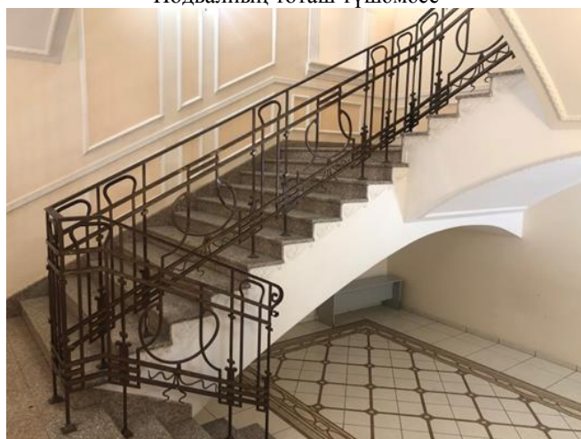
Кирпеч гөмбәзләре буенча үзәк баскыч
