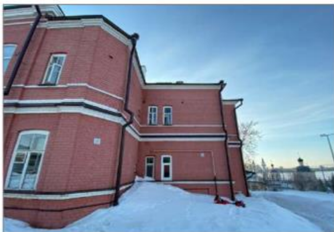
29-30 рәсем. Көнчыгыш фасад; авыш тоташтыргыч кат ара һәм профильле тягалар һәм тәмамлаучы кәрниз. Кат ара профилжле тягалар. Һәйкәл почмагы авышлыгы
