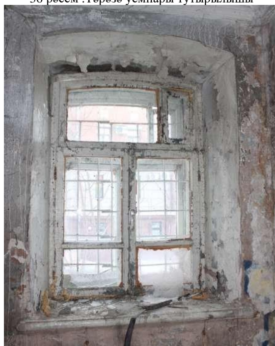
37 рәсем. Тәрәзә; столяр тутырылыш раскладкасы
