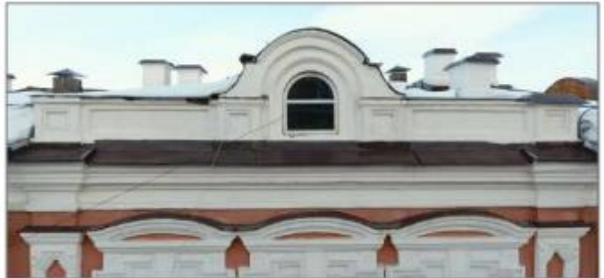
11 рәсем. Тимпанда квадрат һәм турырочмаклы перспектив нишалар һәм ярымциркуль тэрэзэ уемнары белән аттик; торбаларның кирпич чыгарылышлары; кэрнизне чагылдыручы; фасадның үзәк өч күчәрле раскреповкасы (балкон тэрэзэләре); почмакларда һәм ярымтүгэрәкләрдә кирәгеннән артык булган куышлар белән пилястралар фланкировкасы
