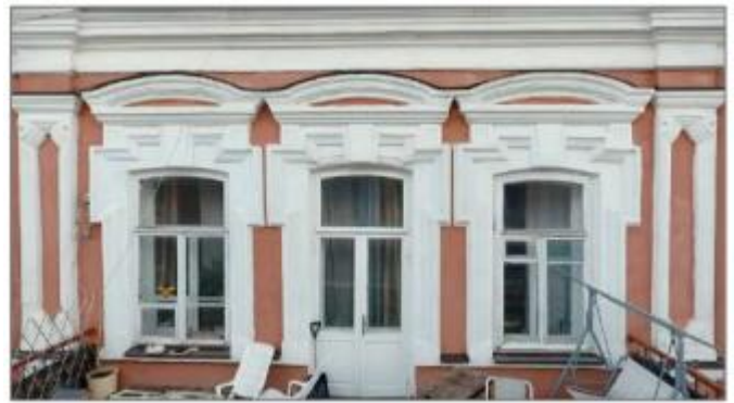
10 рәсем. Уемлы 1әм филекалы пилястрлар. Раскреповка фланкировкасы
