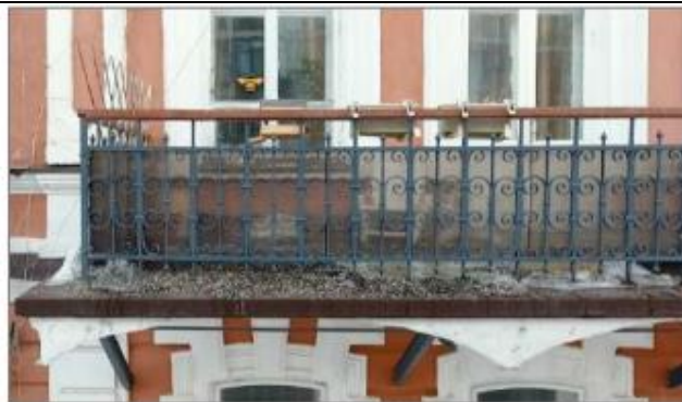
13 рәсем. Челтәрле рәшәткәле һәм металл баганаларда өч өлешле сегмент тоташтыргычлы металл балкон
