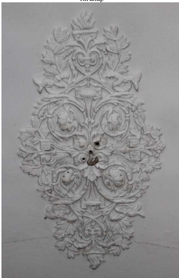
41 рәсем. Галтель кәрниз һәм әвәләп ясаган декор; профильны тягалар
