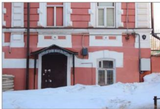
15 рәсем. Беренче катның йомык ташлы тәрәзәсенен штукатур (ясы) йөзлегә. Ишек өстендә авыш түбәле металл зонт.
