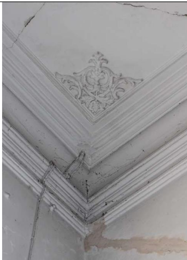
41 рәсем. Галтель кәрниз һәм әвәләп ясаган декор; профильны тягалар
