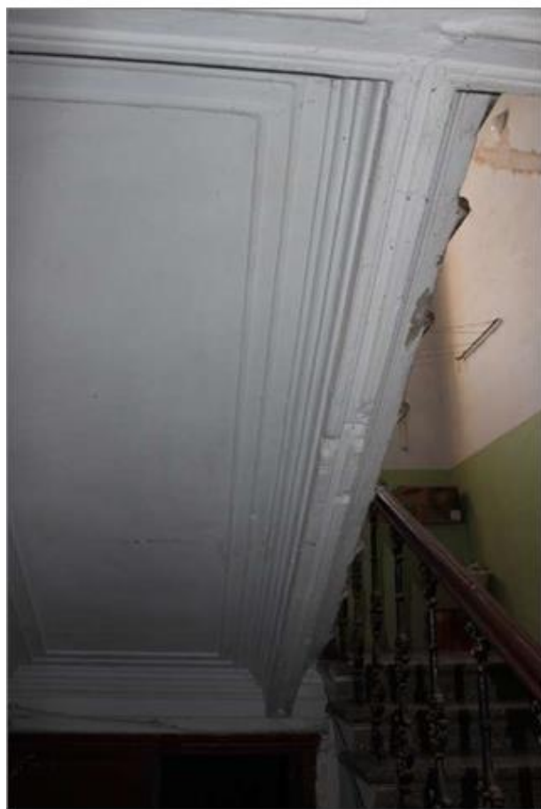
44 рәсем. Баскыч маршы ясылыгында түшәм тыгалары. Металл косоурлар буенча кат ара баскыч.
