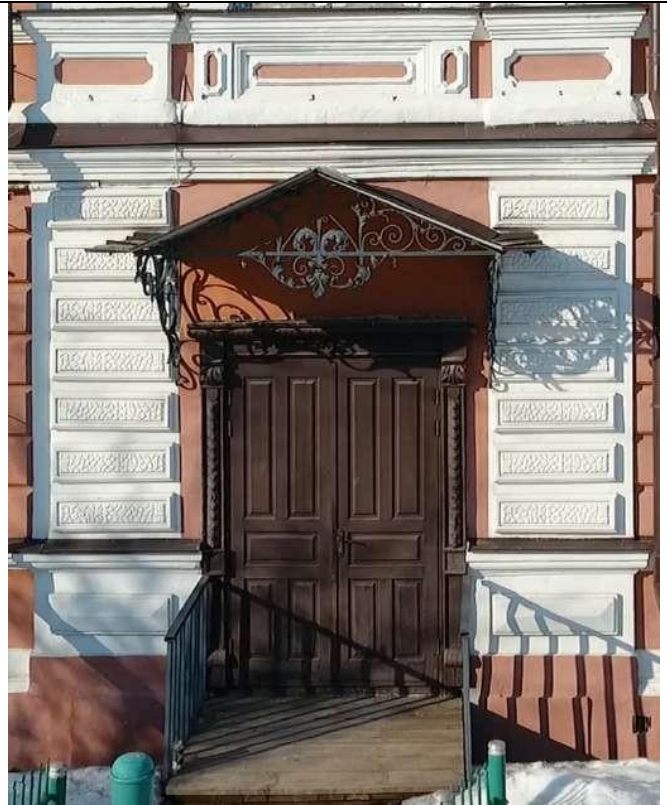
23 рәсем. Авыш түбәле металл зонт. Металлический зонт со скатной кровлей; Ишек кысасының декоратив бизэлеше
