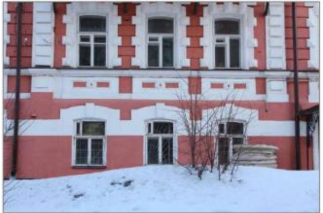
17 рәсем. Икенче кат яссылыгы русты. Түгәрәк розеткалы яткан (горизонталь) профильле тәрәзә төбә уемнары. Тәрәзә төбәндәге профильле тягалар. Икенче кат яссылыгы рустовкасы
