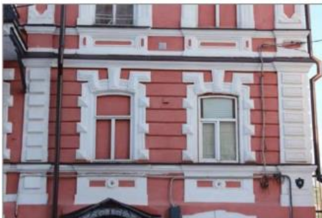
15 рәсем. Беренче катның йомык ташлы тәрәзәсенен штукатур (ясы) йөзлегә. Ишек өстендә авыш түбәле металл зонт.
