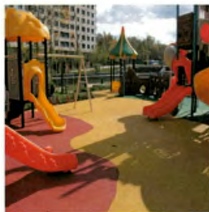
Покрытие площадки на основе резиновой крошки
