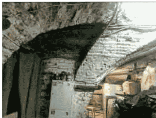
Подвал бүлмәсендә кирпечтән калын цилиндр- лы гөмбәзләр
