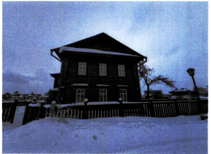
Рис. 3. Вид на северо-западный фасад
