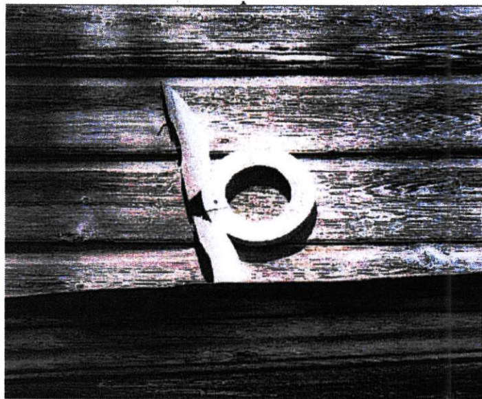
Рис. 24. Резной декор на северном фасаде
