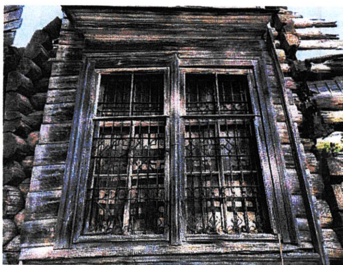
Рис. 47. Окна с переплетом храмовой части южного фасада
