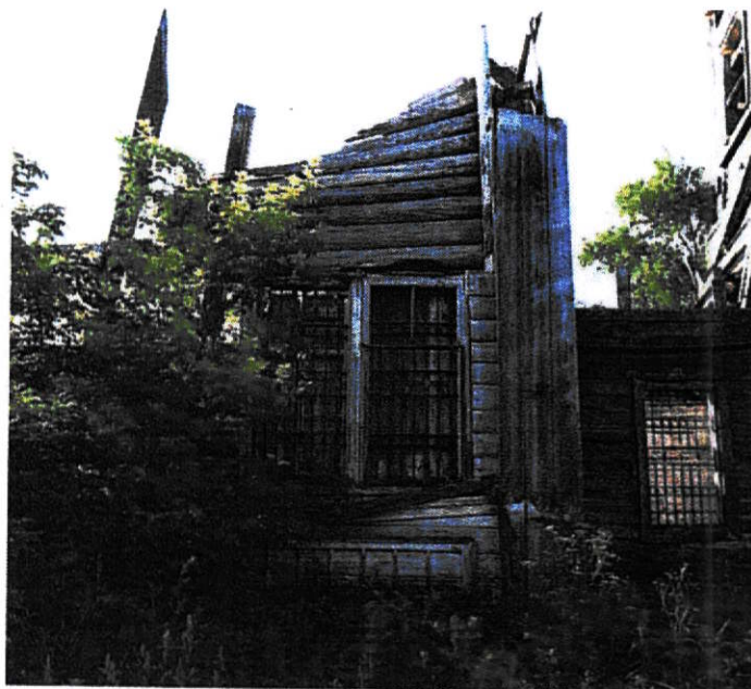
Рис. 27. Фрагмент северного фасада
