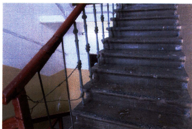
Рис. 15. Лестница. Литые балясины
