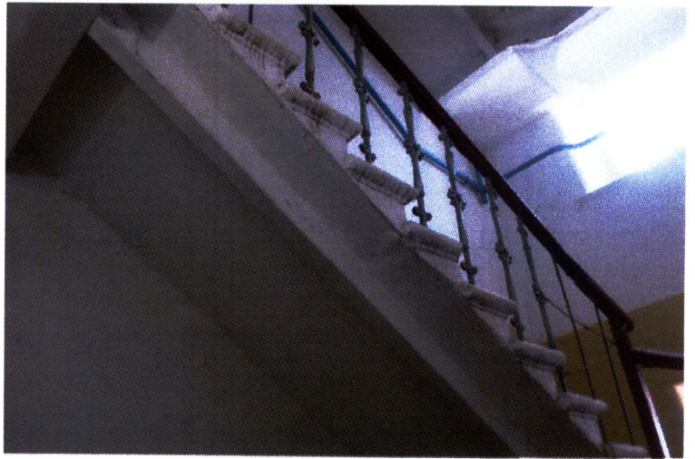
Рис.15. Лестницы. Литые балясины. Литые проступки
