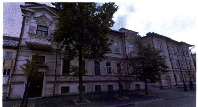
Рис. 3. Общий вид с востока
