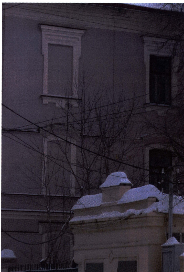
Рис. 8. Фрагмент западного фасада
