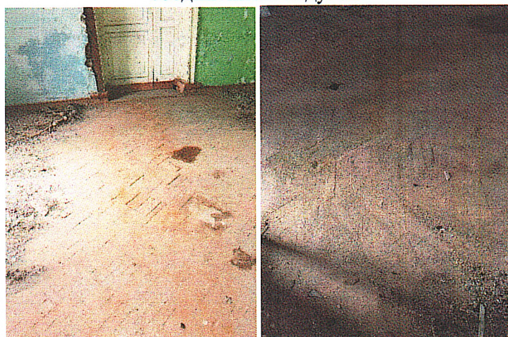
Рис. 32. Исторический штучный паркет в двух анфиладных парадных залах с разным рисунком
