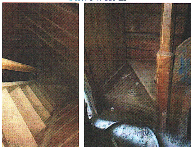
Рис. 35. Деревянная лестница на чердак
