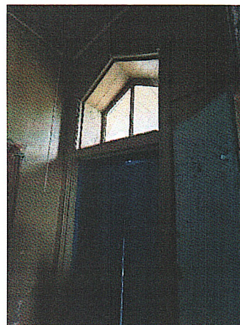
Рис. 23. Исторические наружные двойные двери во двор с остекленной фрамугой с угловым завершением, отделенной импостом от двухстворчатых глухих дверей
