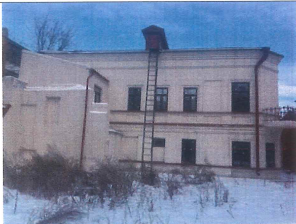
Рис.16. Общий вид дворового фасада
