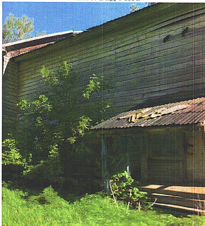
Рис.11. Вид с севера
