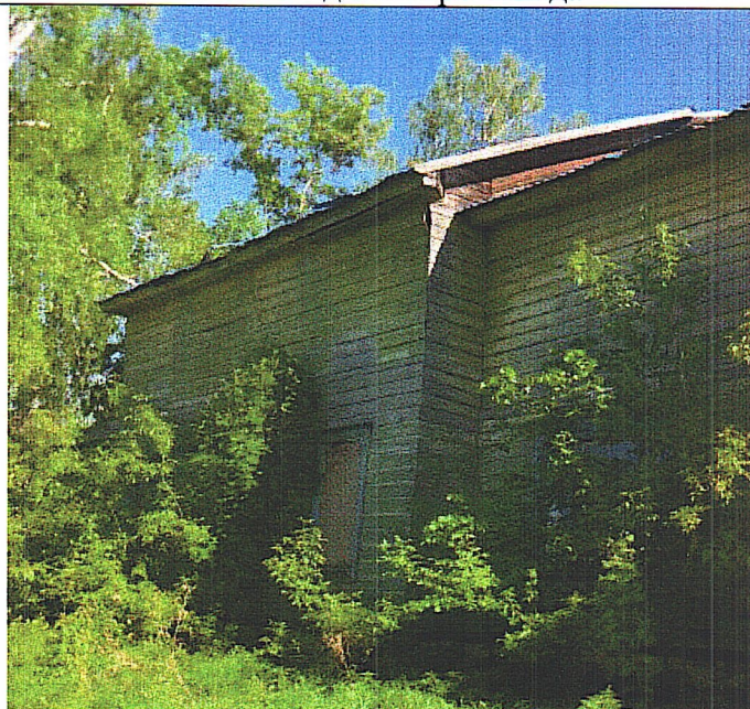
Рис.8. Вид с севера
