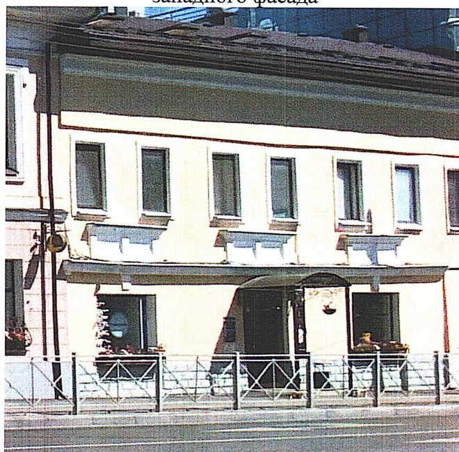
Рис.16. Лавка 3. Оформление проема первого этажа юго-западного фасада
