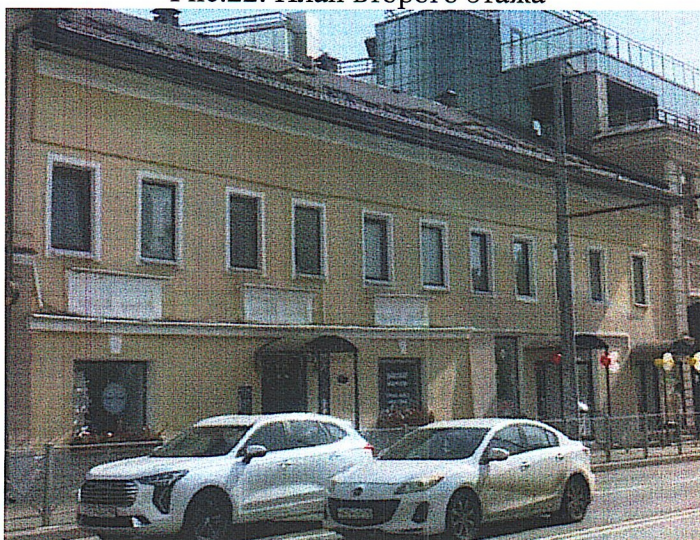
Рис.23. Лавка 3. Лавка 4. Юго-западные фасады лавок
