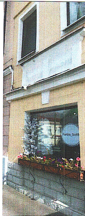
Рис.17. Лавка 3. Оформление проема первого этажа юго-западного фасада
