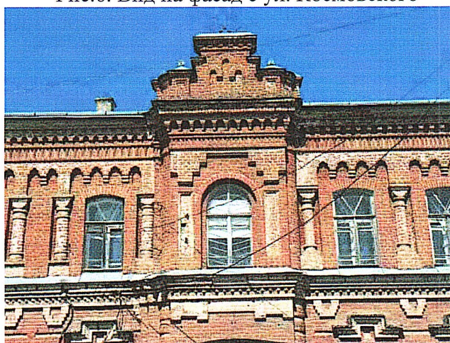
Рис.7. Парапет (аттик), со встроенной аркой и филенками на парапетных столбиках
