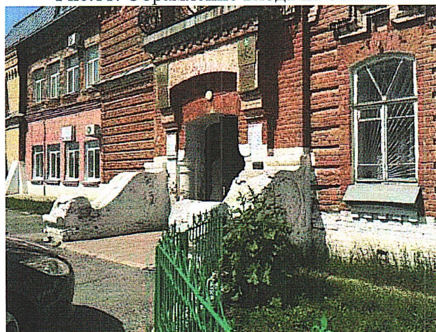
Рис.12. Ограждение крыльца с растительным орнаментом
