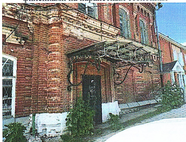
Рис.8. Кованный навес, с литыми элементами растительного характера и буквой «К» в центральной части
