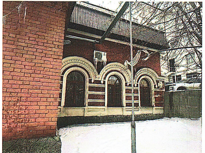
Рис.8. Оконные проемы юго-восточного фасада
