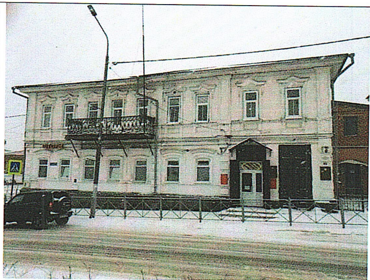
Рис.13. Оконные проемы первого и второго этажей
