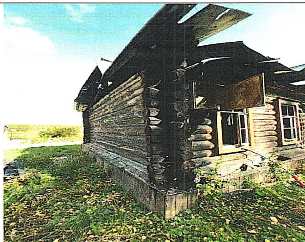
Рис. 4. Вид с юго - запада
