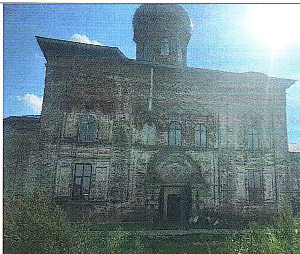
Рис.9. Вид с севера
