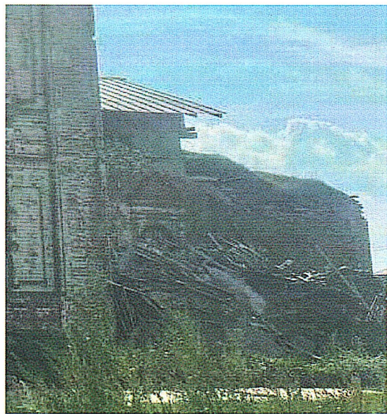
Рис.4. Вид с севера
