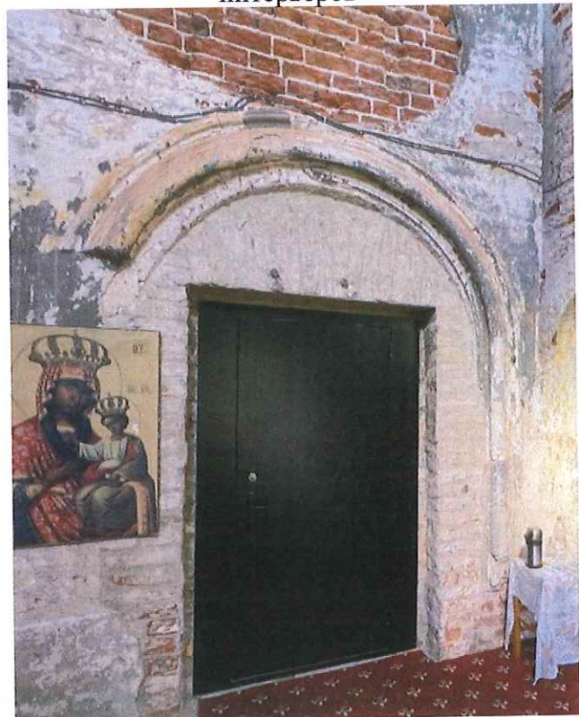
Рис.23. Арочные завершения между храмом и трапезной
