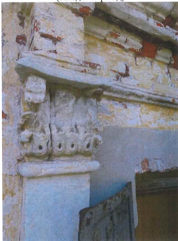
Рис.17. Дверной наличник северного фасада с резной белой капителью
