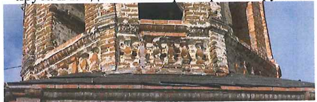
Рис.6. Пояски, карнизы из профилированного кирпича на фасадах
