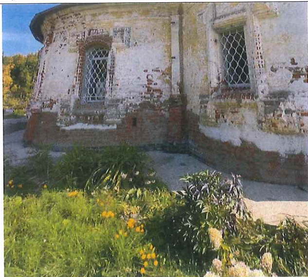
Рис.14. Оконные проемы на уровне первого этажа
