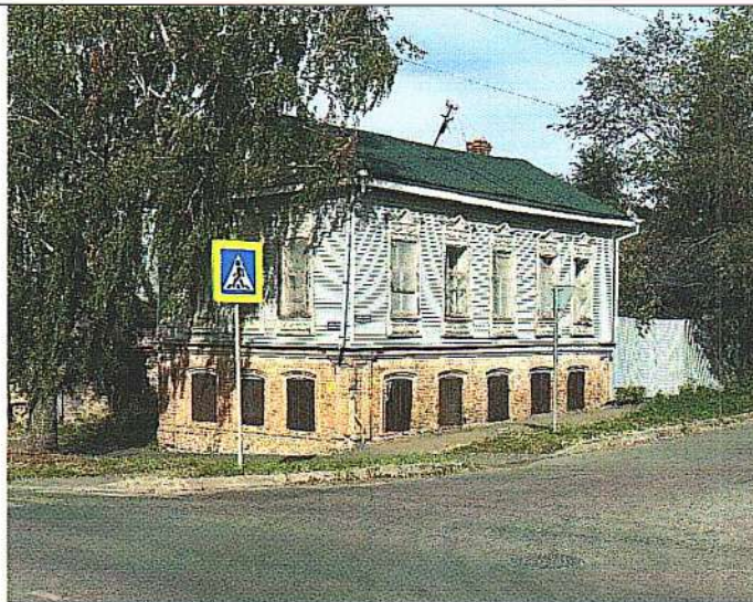
Рис.7. Общий вид с перекрёстка
