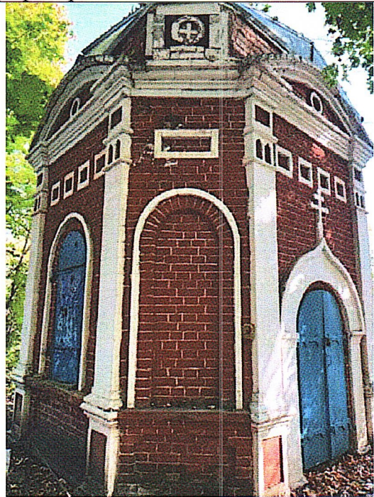
Рис.9. Вид на юго-запад. Арочные ниши проемов входа и окон
