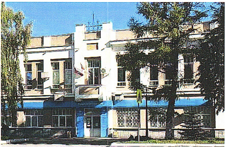
Рис. 7. Вход со стороны главного фасада
