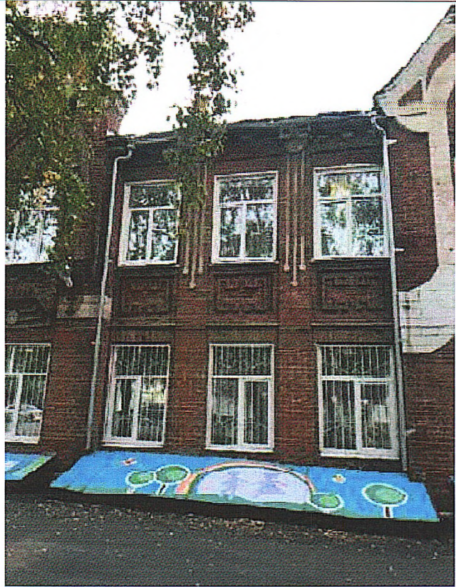
Рис. 4. Вид в северо-западном направлении на центральную часть главного фасада и приямки
