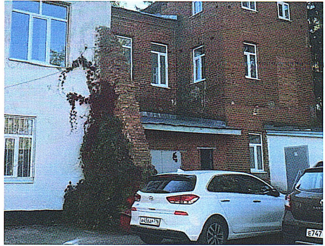
Рис. 15. Вид в юго-западном направлении на исторический контрфорс
