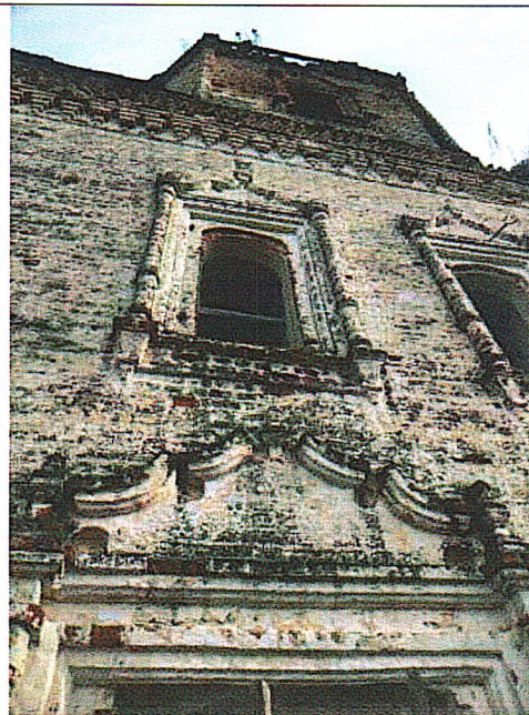
Рис. 4. Вид с северо-запада. Фрагмент храмовой части. Окна.
