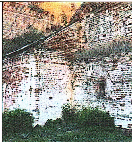
Рис. 9. Вид с запада. Примыкание трапезной к колокольне.
