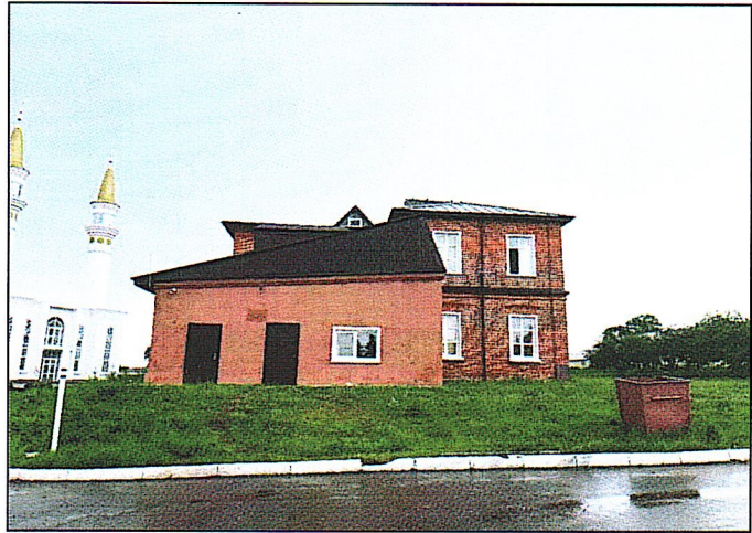
Рис. 9. Восточный фасад, на первом плане поздний пристрой
