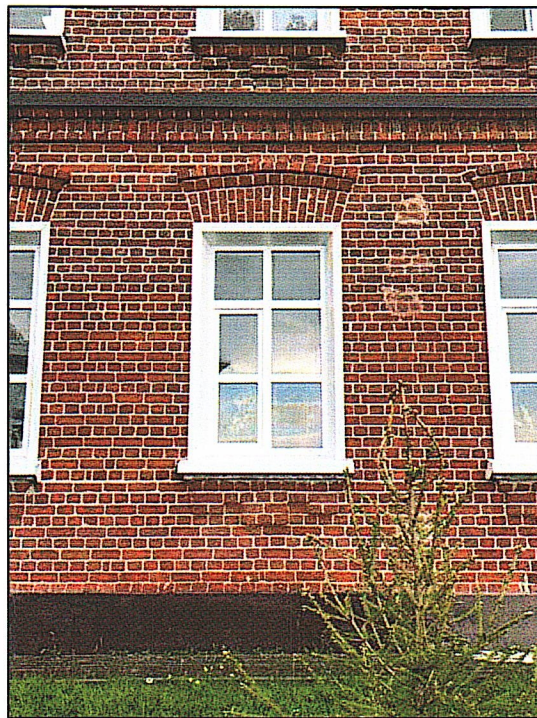
Рис. 10. Оконные проемы первого этажа с лучковой перемычкой и сандриком, подоконные полочки с орнаментом, межэтажный фриз-пояс
