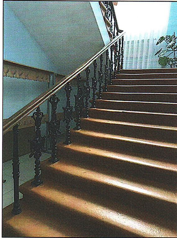
Рис. 13. Историческая межэтажная 2-х маршевая каменная лестница с балясником художественного литья и профилированными перилами
