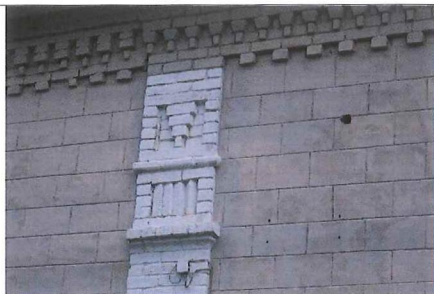
Рис. 15. Раскреповка фасадов лопатками с декором
