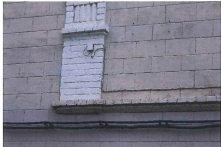
Рис. 26. Фрагмент западного фасада
