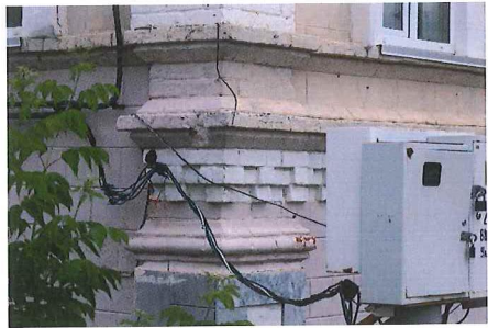
Рис. 13. Подоконный карниз
