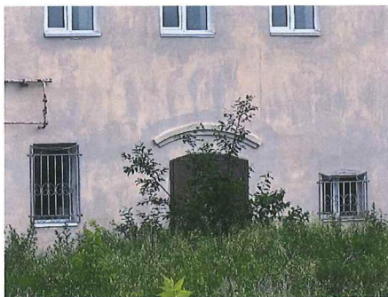
Рис. 24. Дверной проем северного фасада
