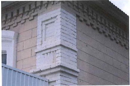
Рис. 22. Лопатка северо-восточного угла
