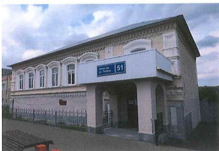
Рис. 6. Вид на южный фасад при движении по ул. Ленина с юго-востока (точка 4)
