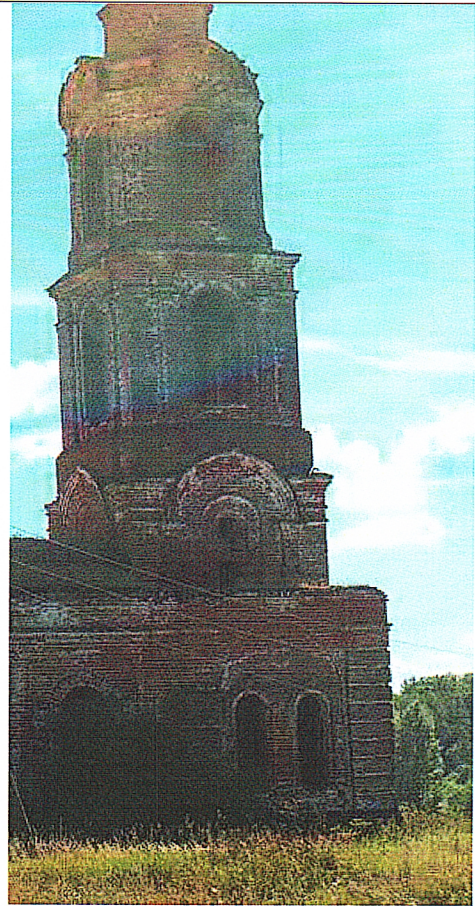
Рис. 5. Вид с севера
